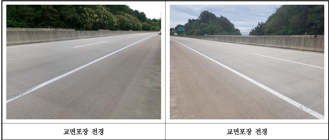
【사진 6.3.18】 교면포장 전경
