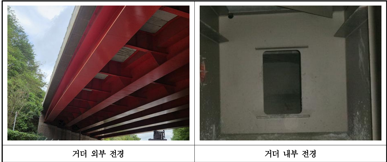
【사진 6.3.27】 거더 전경
