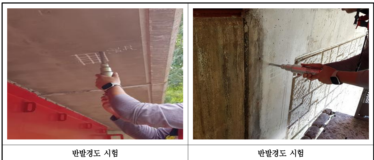
【사진 6.4.2】 반발경도시험 현장사진
