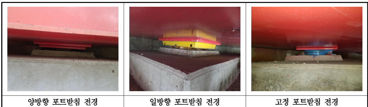
【사진 6.3.34】 교량받침 전경
