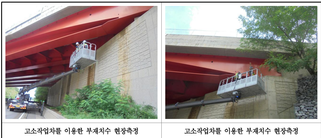
【사진 6.2.1】 부재 현장측정 전경
