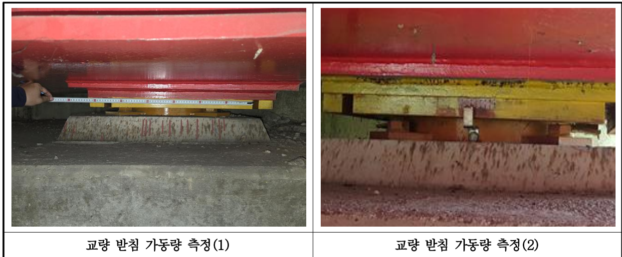
【사진 6.3.14】 교량받침 이동량 측정
