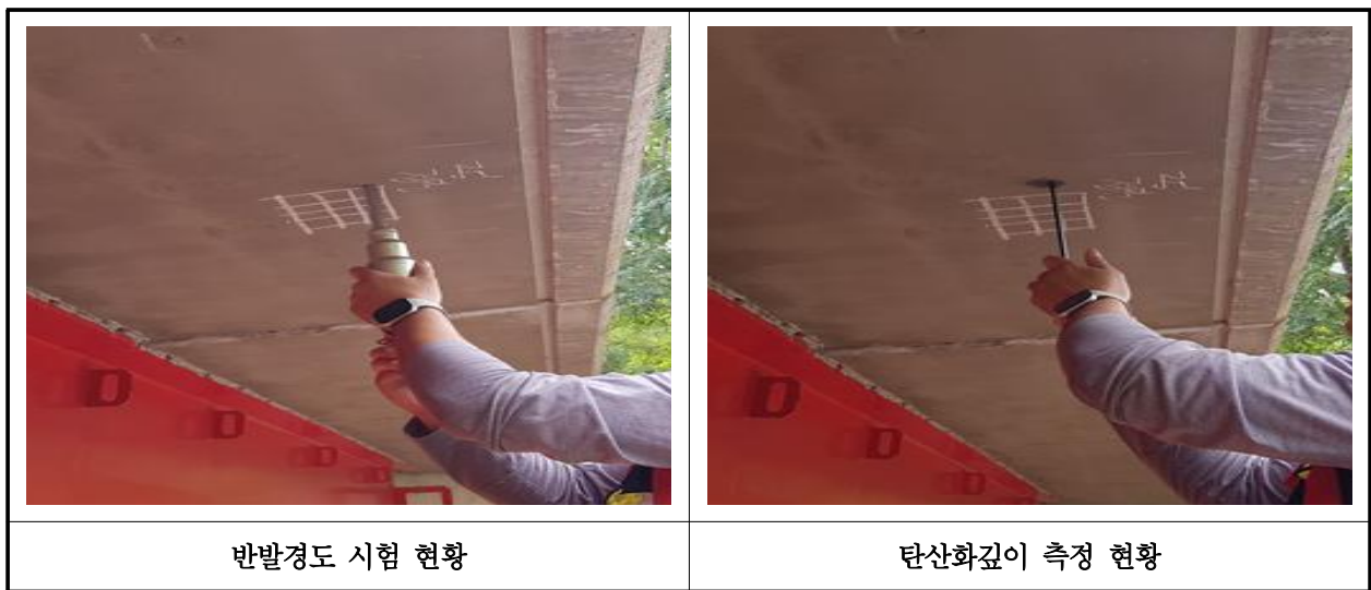
【사진 6.4.1】 콘크리트 내구성조사 현황
