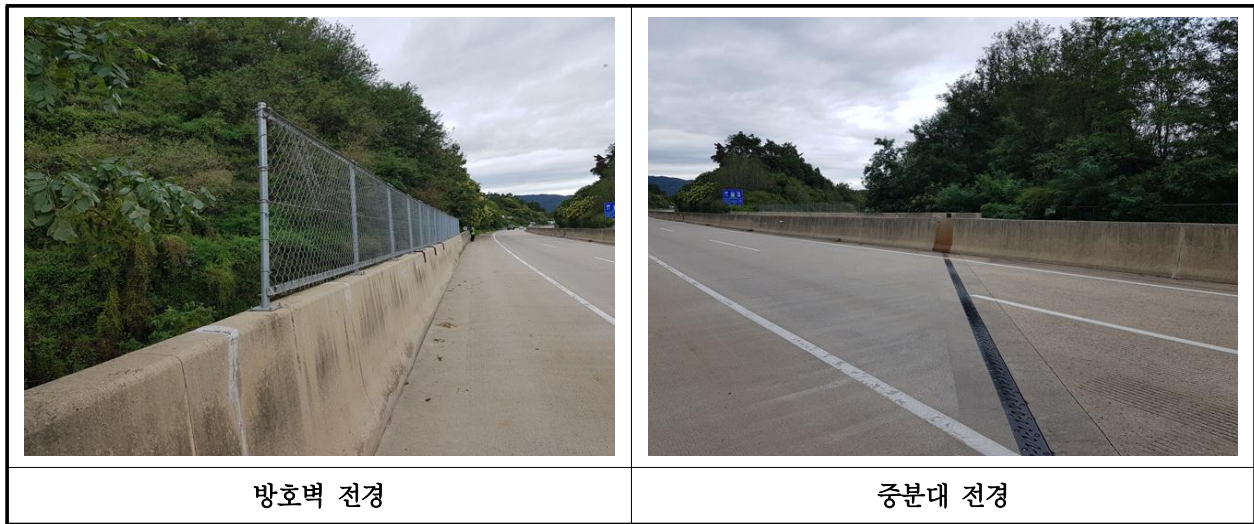
【사진 6.3.45】 방호벽 및 중분대 전경
