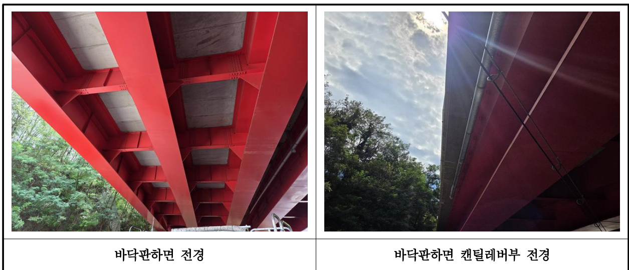
【사진 6.3.2】 바닥판하면 전경
