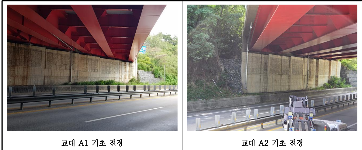
【사진 6.3.10】 기초 전경
