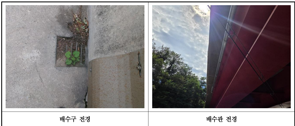
【사진 6.3.20】 배수시설 전경
