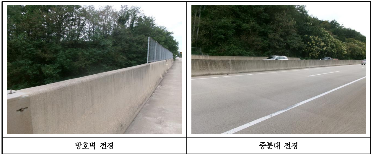
【사진 6.3.22】 방호벽 및 중분대 전경
