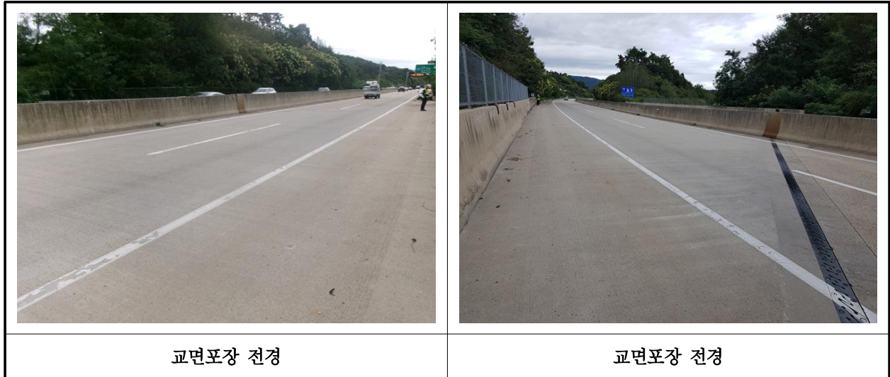
【사진 6.3.41】 교면포장 전경
