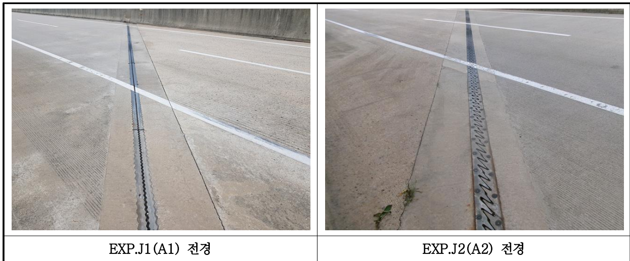
【사진 6.3.15】 신축이음장치 전경
