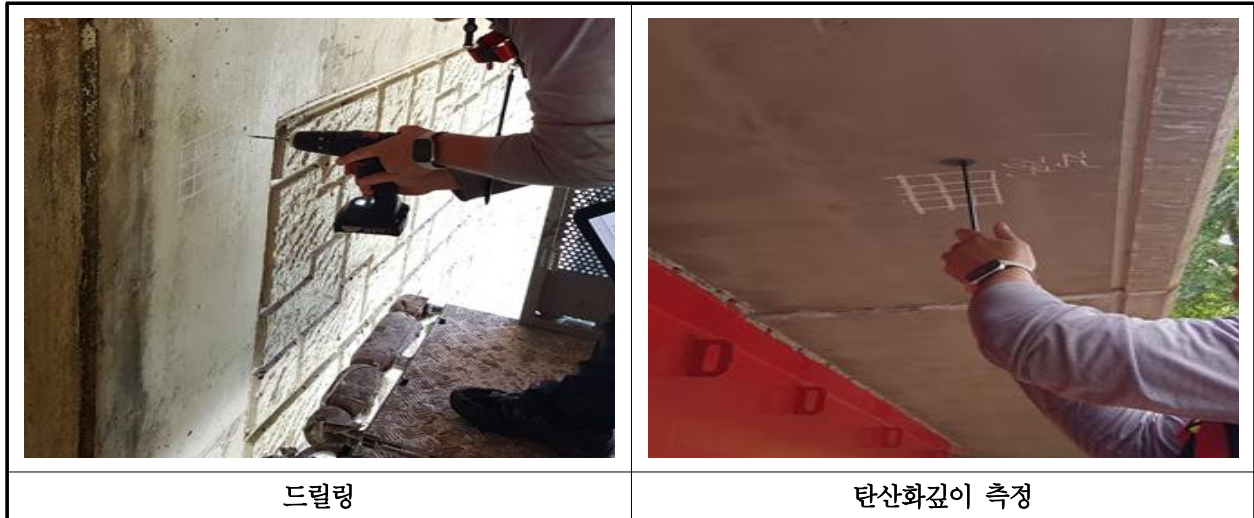
【사진 6.4.3】 탄산화 깊이 측정 현장사진
