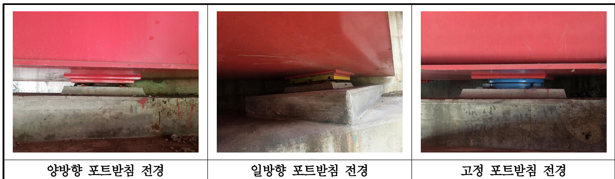
【사진 6.3.11】 교량받침 전경
