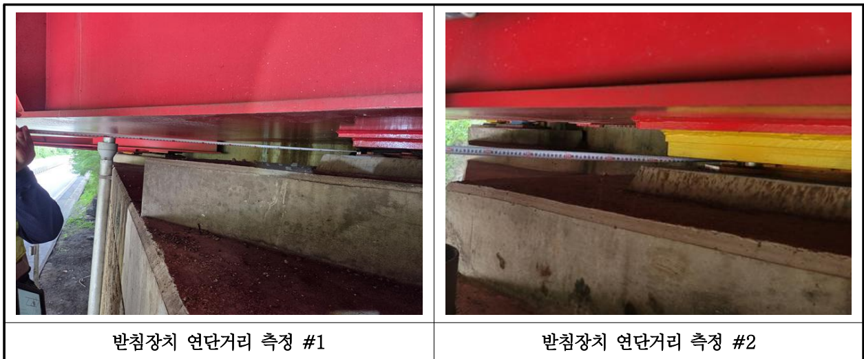
【사진 6.3.36】 교량받침장치 연단거리측정
