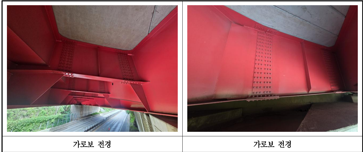
【사진 6.3.29】 가로보 전경
