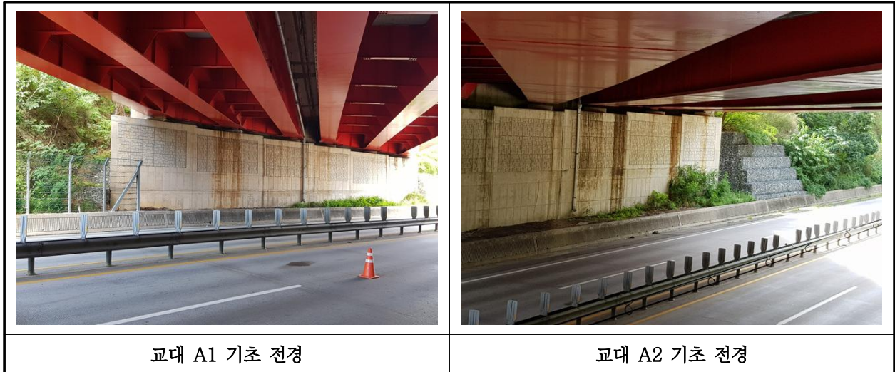
【사진 6.3.33】 기초 전경
