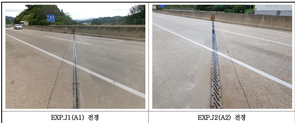
【사진 6.3.38】 신축이음장치 전경
